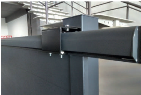
4.1. Fixez la pièce de guidage sur le poteau aluminium.
