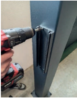
3.1. Vissez le support de réception sur le pilier aluminium.
