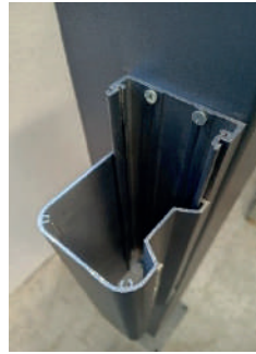
3.2. Emboîtez la butée de réception sur le support.
